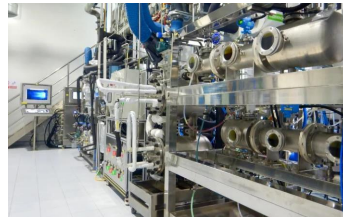
常州基地新的连续化生产车间
