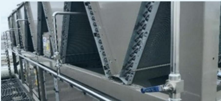
风冷热泵翅片喷淋散热管道改造
