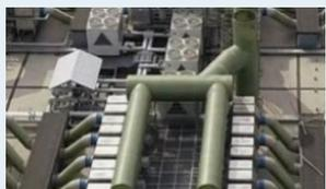
重新设计分离实验室，以封闭管道进行溶剂供应和废液排放，降低 VOC 排放。
