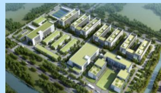
常熟 原料药开发与生产 正在建造 预计2021年12月完工
