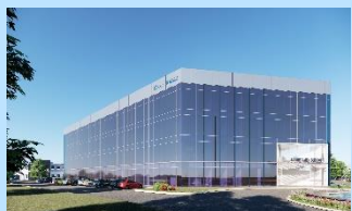
美国特拉华州 原料药开发与生产 制剂开发与生产 正在建造 预计2025年开始投入运营
